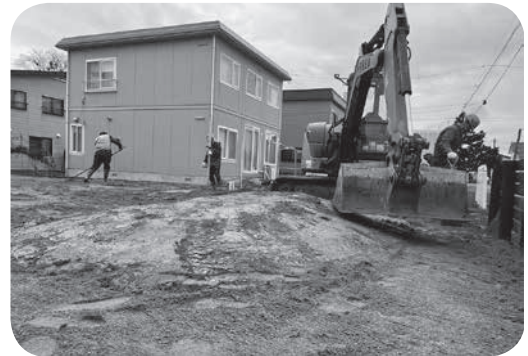
建設業協会の重機を使った整地作業 4月23日
