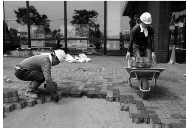
砂の上にブロックを敷き詰める作業員たち
